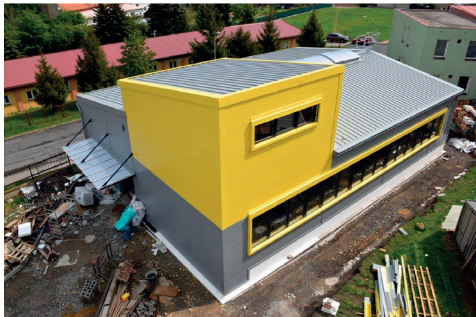
Celkový pohled na stavbu nového Centra vzdělávání klempířů ve Stochově
